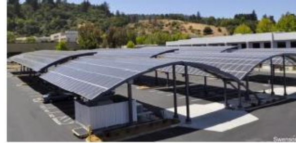
شكل ٢١ تركيب الخلايا الشمسية المرنة علي الاسطح والمقوسة.
