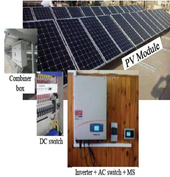
شكل ٢٢ يوضح مكونات نظام الخلايا الشمسية المثبتة على مبنى كلية الهندسة جامعة بنها بنظام On Grid
