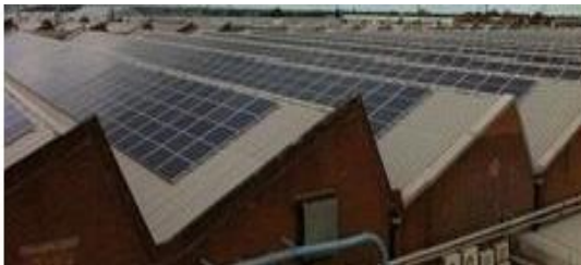
شكل ١٨ تركيب الخلايا الشمسيه علي الاسطح المسننه.
