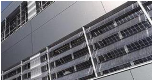
شكل ١٩ الخلايا الشمسيه تعمل كاسرات للشمس او كجدران ستائريه او تغطيه للاسطح الرأسية.
