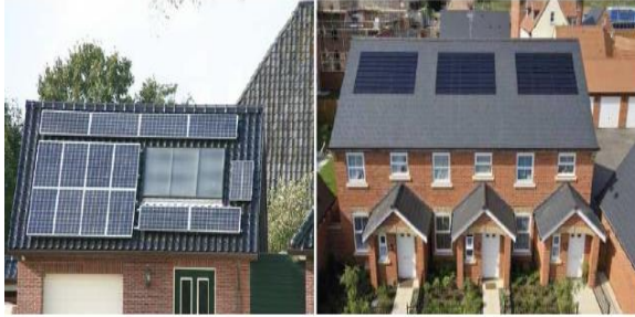
شكل ١٦ يوضح تركيب الخلايا الشمسيه بشكل مائل للاسطح الافقيه
