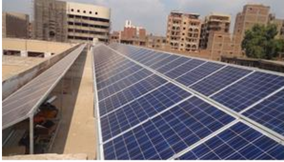
شكل ٢٤ يوضح سطح مبنى المحافظة اثناء تركيب الخلايا الشمسية عام ٢٠١٥
