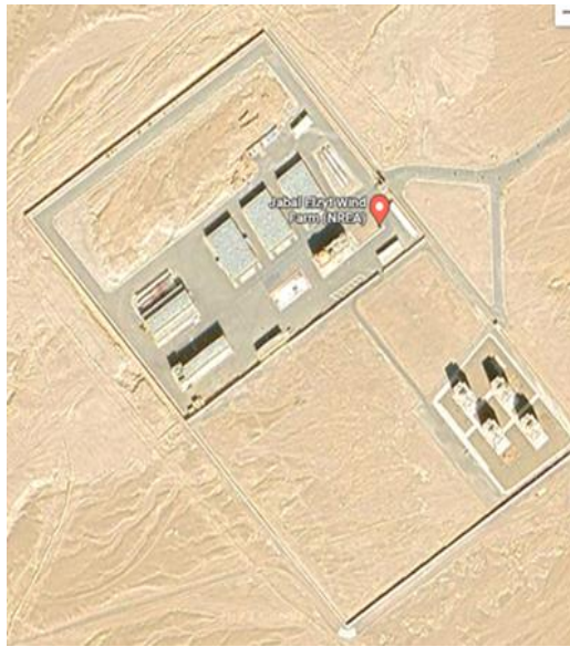
شكل (٩) محطة جبل الزيت ٥٨٠ ميجاوات [١٤]
