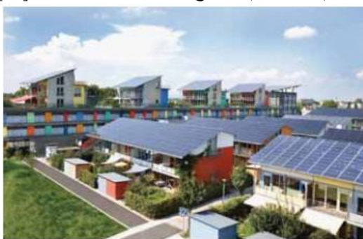
شكل (١٧) يوضح استخدام الواح الطاقة الشمسية فوق اسطح المباني السكنية في حي فويان بمدينة فريديبورغ [٤١]
