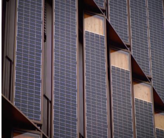
شكل (١٩) يوضح وحدات هجينة على سطح قاعة المدينة ("Rathaus am Stühlinger") لمدينة فرايبورغ تولد الكهرباء والحرارة. [٤٣]
