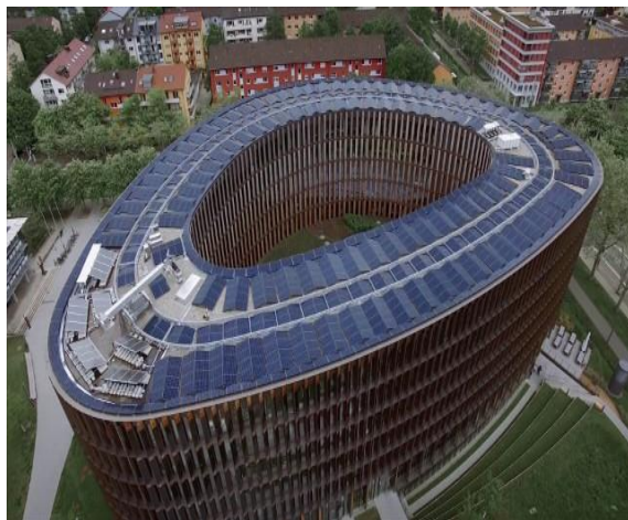
شكل (١٨): يوضح دمج الألواح الكهروضوئية العمودية كإجهزة تظليل شمسية في واجهة مركز إدارة المدينة في فرايبورغ، ألمانيا. يصبح مستهلك الطاقة مورداً للطاقة [٤٣]
