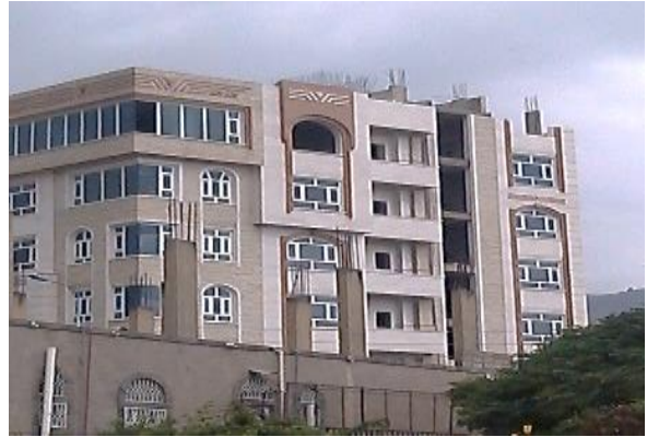
شكل (4) مبنى سكني انشأ بتقنيات انشائية حديثة (الباحثان، 2021)
