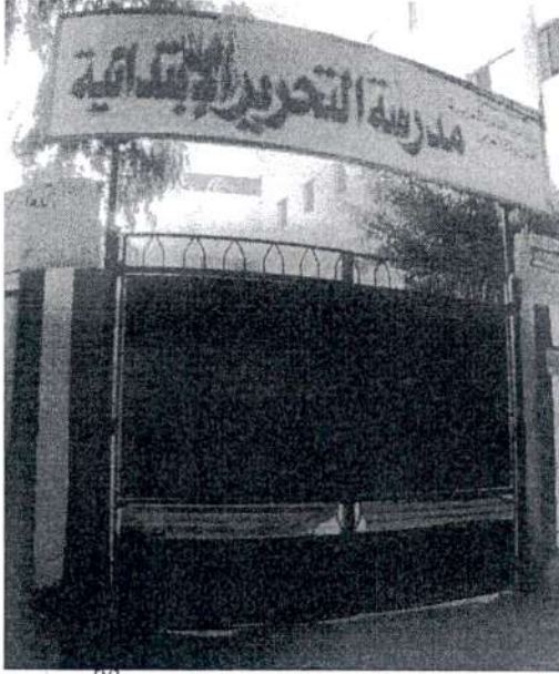
شكل (١٠): نموذج محلي لمدخل المدرسة. [٧]
